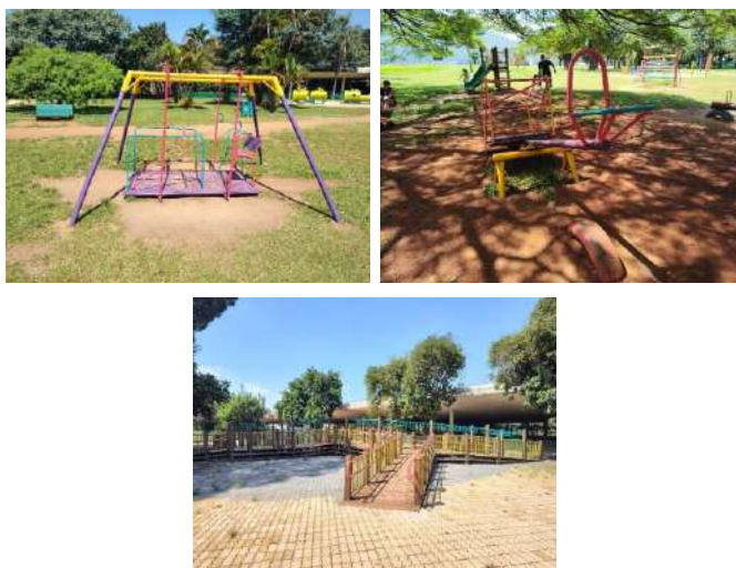
Figura 81: pintura e reparo nos brinquedos acessíveis do parquinho do auditório.
