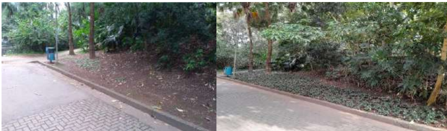
Figura 58- Revitalização do Talude em frente a Sabesp
